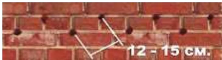
Рисунок 4.6 – Схема размещения шпуров
