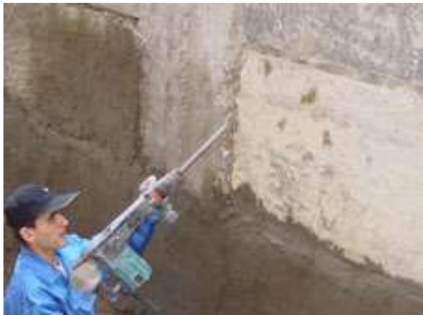
Рисунок 4.1 – Расшивка шва электроперфоратором
